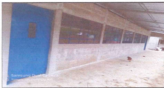
Foto 5: Acá podemos observar las dos puertas metálicas ya puestas.
