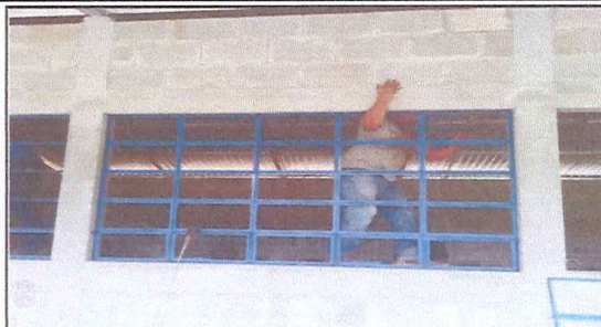
Foto 2: Colocando los primeros ventanales
