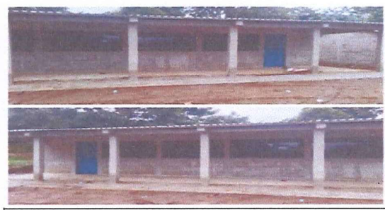
Foto 6: Aca podemos observar la escuela totalmente finalizada.
