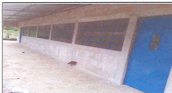
Foto 3: finalizando con la colocación de las ventanas
