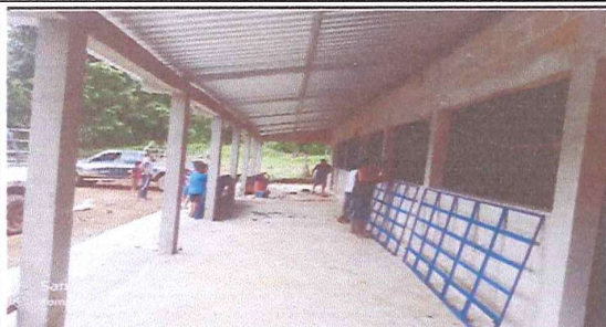
Foto 1: Iniciando con la colocación de las ventanas
